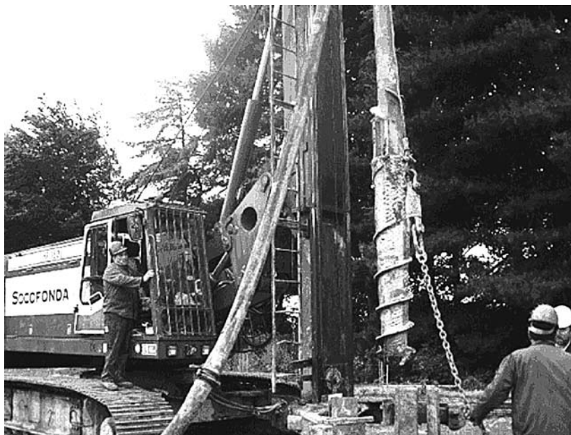
Рис. 43. Общий вид работ по изготовлению свай по технологии «Омега»
